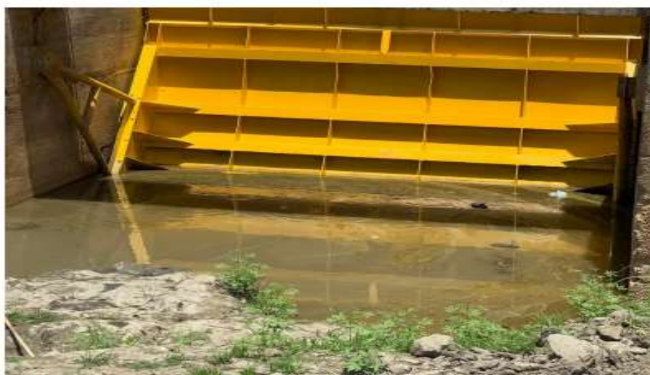
LUGAR: COMPUERTAS EL PORVENIR DESCRIPCION: SE OBSERVA LABORES TERMINADOS DE PINTURA DE LAS COMPUERTAS Y FUNCIONANDO EN OPTIMAS CONDICION
