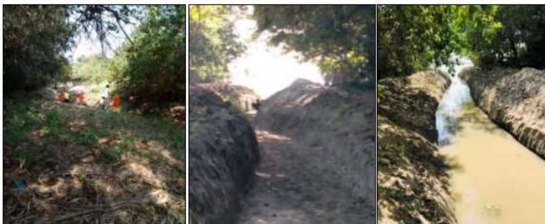
Imagen. Intervención de los humedales limpieza manual estructura de caño la luisa – compuerta 2 (1000X 4M) SANTO TOMAS.
