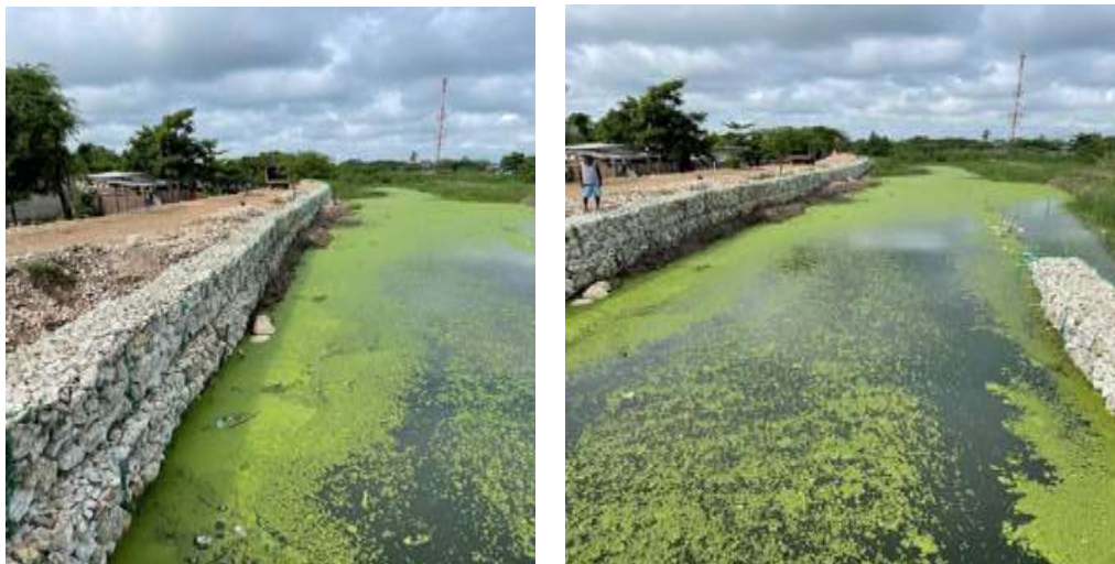
Imagen 24: Construcción de muro de gavión margen izquierda y derecha aguas hacia arriba
