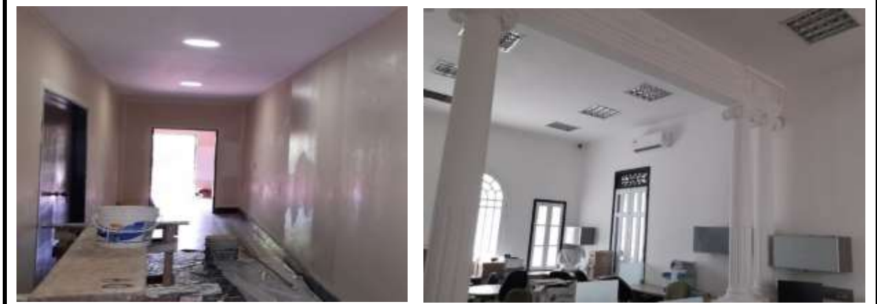
Mantenimiento a instalaciones locativas.
