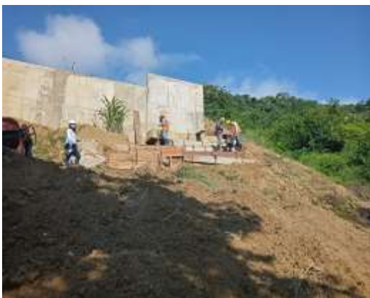
Construcción de gaviones y estabilización de taludes
