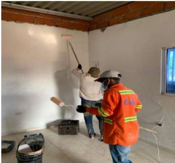
LUGAR: COMPUERTAS EL PORVENIR DESCRIPCION: SE OBSERVA LABORES LABORES DE PINTURA SOBRE N
