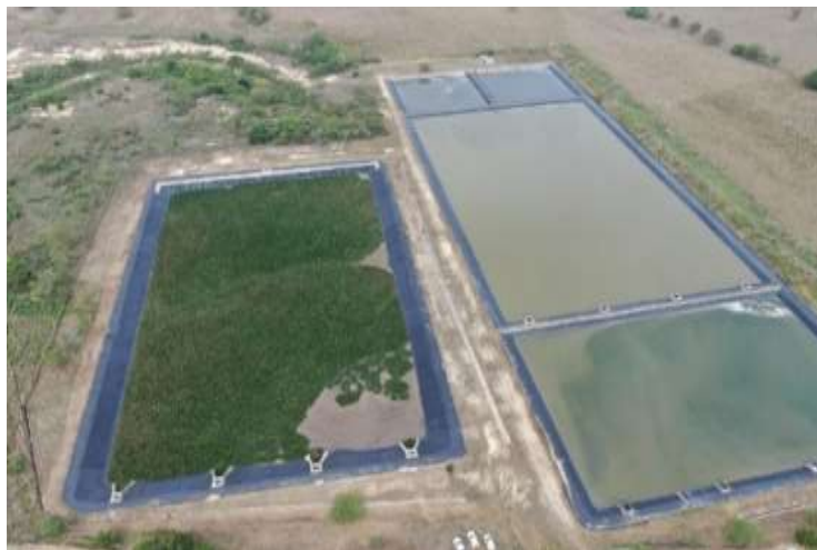
Seguimiento al PSMV del municipio de Baranoa. Foto: 5 módulos de la EDAR en funcionamiento. Lugar: EDAR Baranoa. Fecha: 25 de mayo de 2021
