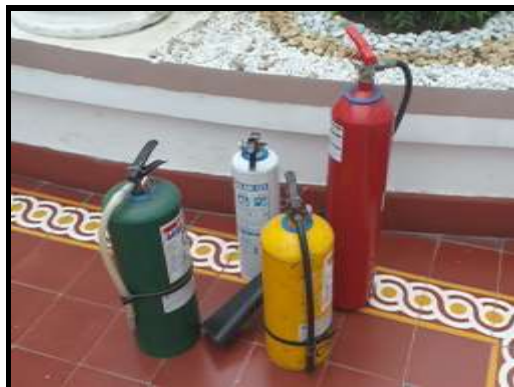
Recarga de extintores
