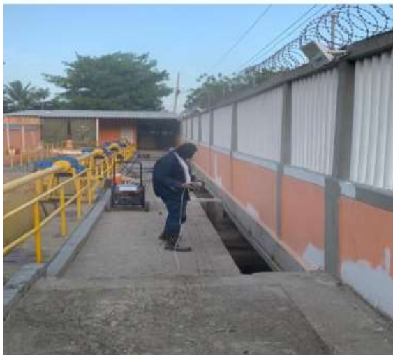
LUGAR: COMPUERTAS EL PORVENIR DESCRIPCION: SE OBSERVA LABORES DE INSTALACION DE REJILLAS .
