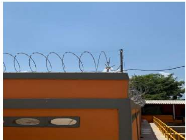
LUGAR: COMPUERTAS EL PORVENIR DESCRIPCION: SE OBSERVA LABORES TERMINADOS DE INSTALACION DE SISTEMA TIERRA Y PARARRAYOS
