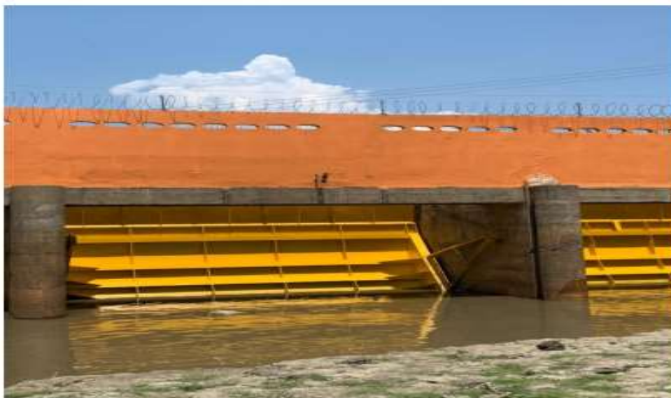
LUGAR: COMPUERTAS EL PORVENIR DESCRIPCION: SE OBSERVA LABORES TERMINADOS DE PINTURA DE LAS COMPUERTAS Y FUNCIONANDO EN OPTIMAS CONDICION
