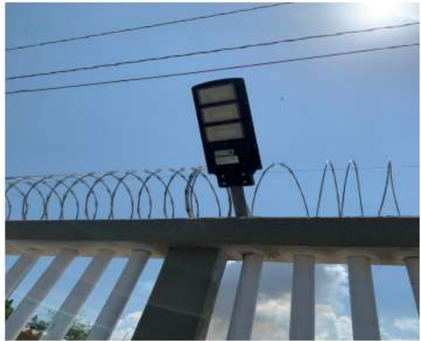
LUGAR: COMPUERTAS EL PORVENIR DESCRIPCION: SE OBSERVA LABORES TERMINADOS DE INSTALACION DE REFLECTORES SOLARES.
